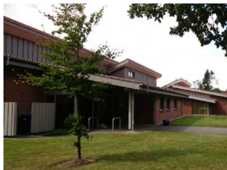
Für die Kinderkrippe wurde ein dritter Gruppenraum gebaut.
