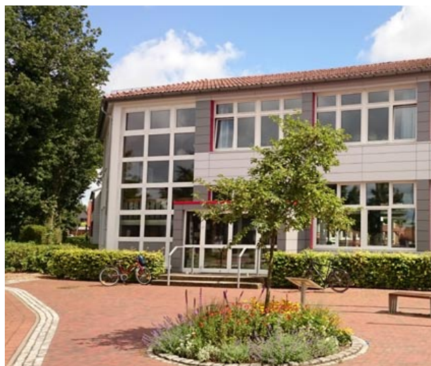
Die Sanierung der Oste-Hamme-Schule ist klasse und geht weiter.
